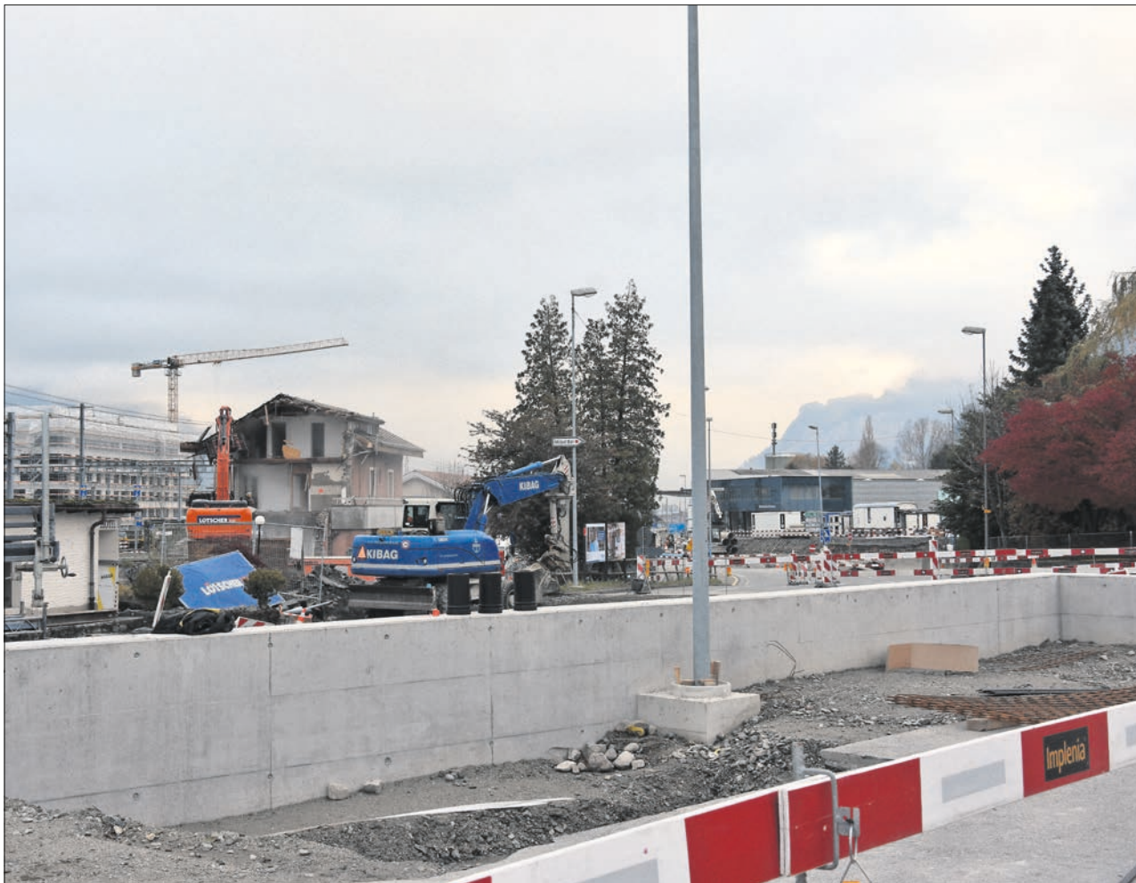
Die Bauarbeiten für den Kantonsbahnhof haben begonnen. Der Bund unterstützt dieses Projekt im Rahmen des Agglomerationsprogramms.
