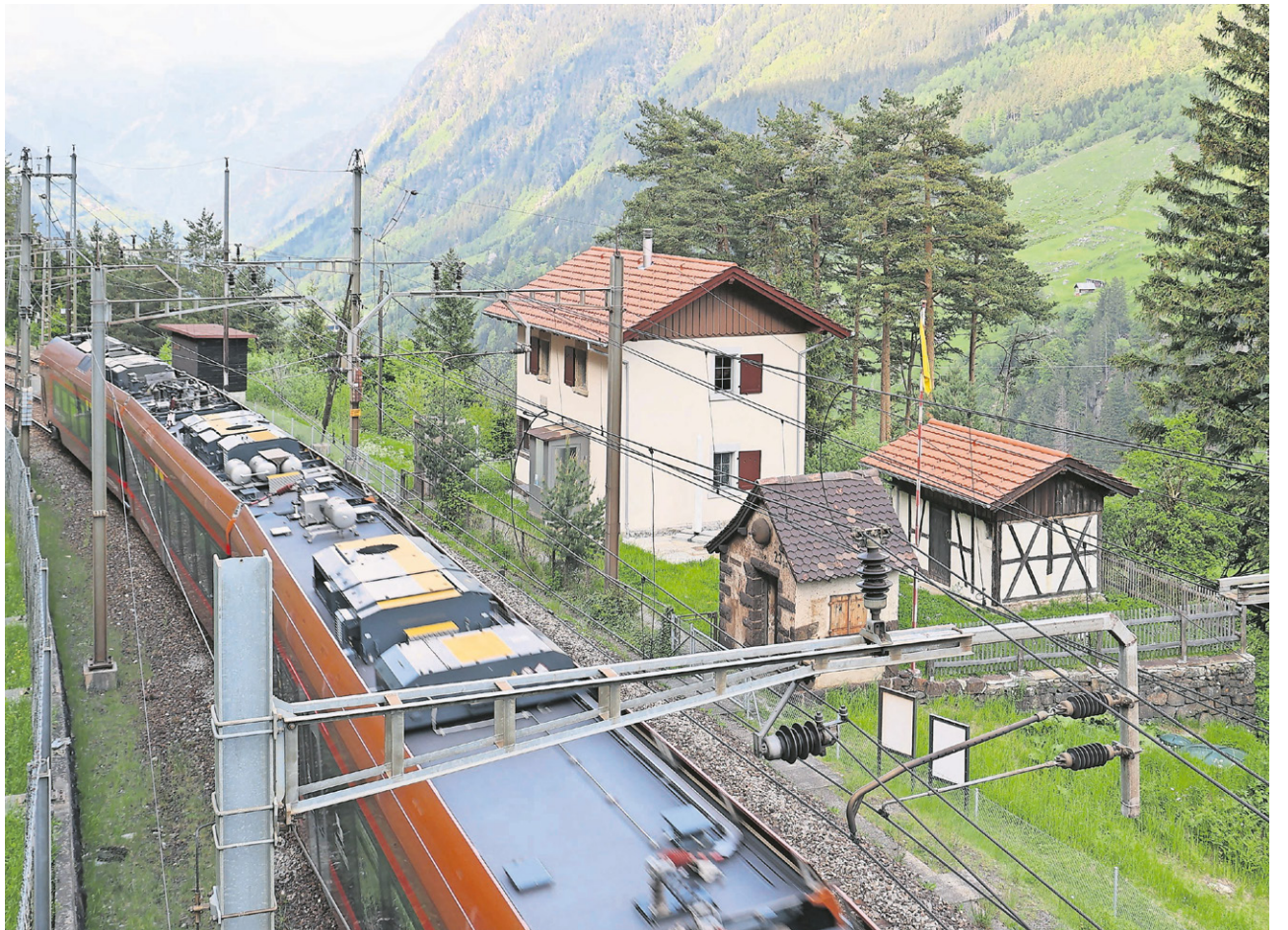
Das Bahnwärterhaus Eggwald liessen die SBB 2020 vorbildlich sanieren. Heute wird es als Ferienhaus direkt an der Schiene vermietet. Gäste können Zügen, wie auf dem Foto dem Treno Gottardo, ganz nah sein. FOTO: KILIAN T. ELSASSER
